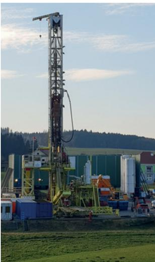
Im Auftrag von der GRB GmbH (Geothermie Ried Bohrung) ist für die neuerliche Ausführung der Tiefbohrarbeiten die Firma Züblin Spezialtiefbau (eine Tochterfirma von STRABAG) verantwortlich. Kooperiert wird in Arbeitsgemeinschaft mit dem spezialisierten Bohranlagenhersteller Firma Huisman Equipment. In einer Tiefe von ca. 2700 m wird geothermales Wasser mit einer Förder-temperatur bis zu 110 °C erwartet.
